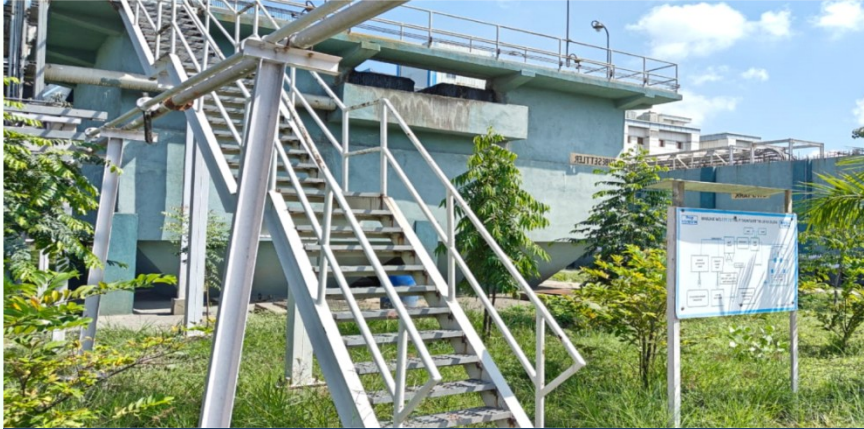
Effluent Treatment Plant (ETP)
